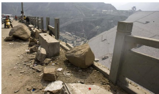
Рис. 1. Вид плотины «Зипингпу» после землетрясения [2, 3]
