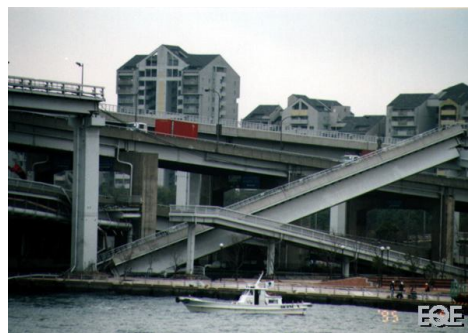
Рис.1. Падение пролетного строения транспортной развязки в Кобе (Япония, 1996г.)
